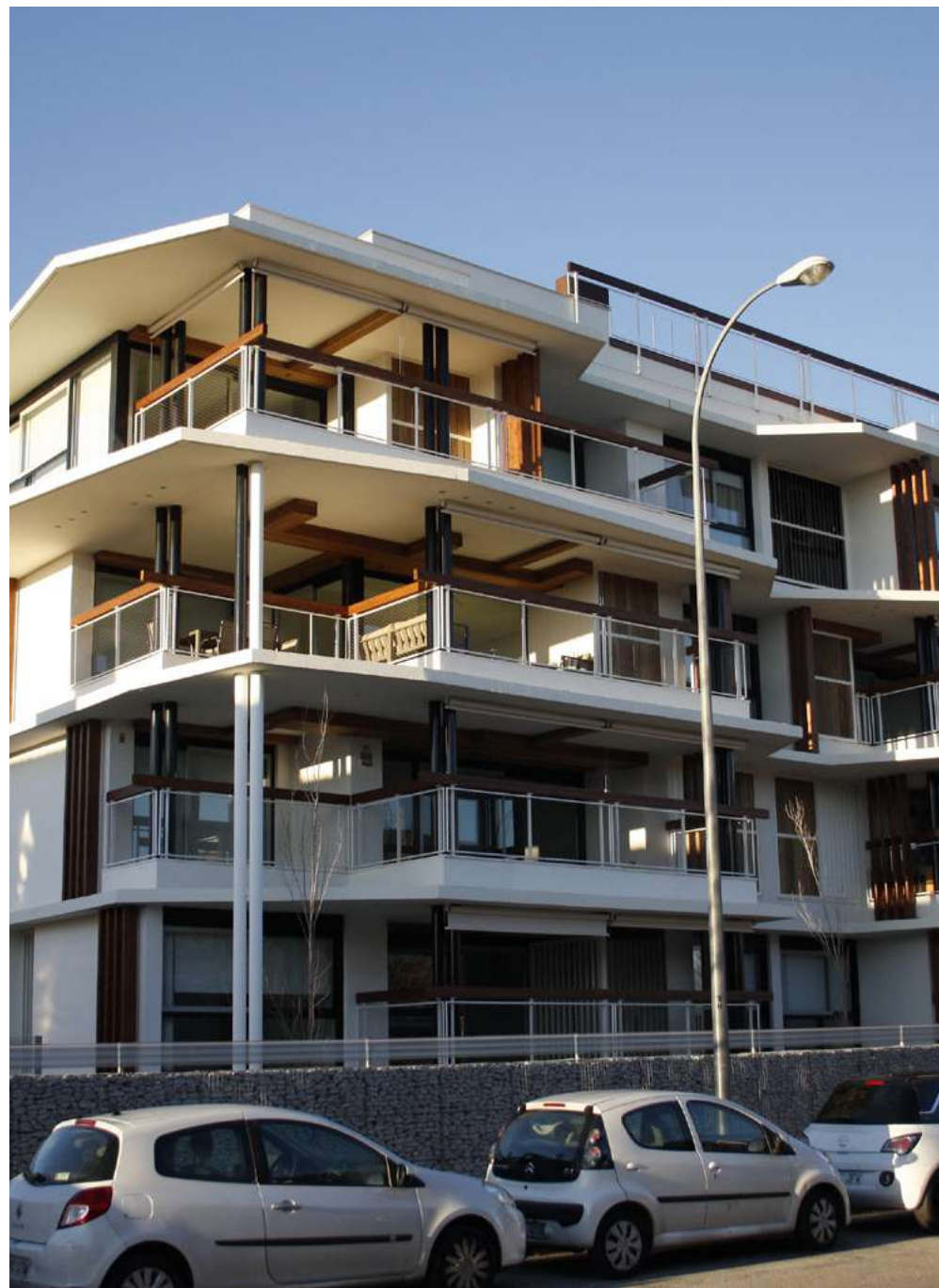
EDIFICIO MIRASIERRA · BOADILLA DEL MONTE, MADRID
